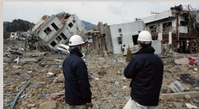
被災状況調査 (宮城県女川町)
