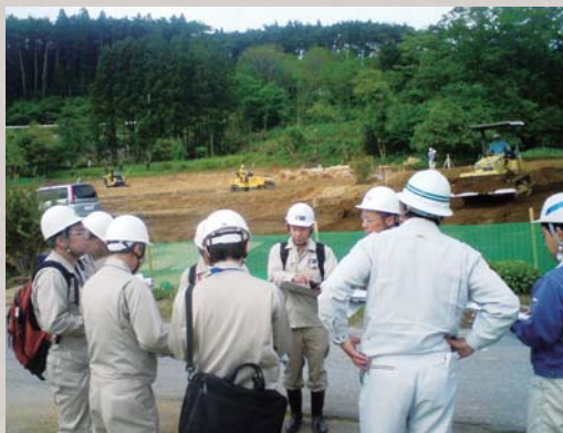
建設現場 (陸前高田市) の様子
